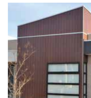
סיום: לאחר 3 שכבות ציפוי העץ שוקם ומוגן כעת מפני קרינה אולטרה סגולה. יש לשמור על הצבע לאורך זמן על פי הוראות התחזוקה של המוצר.
